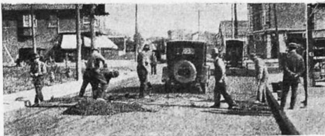
Работы по устройству дороги из эмизита
