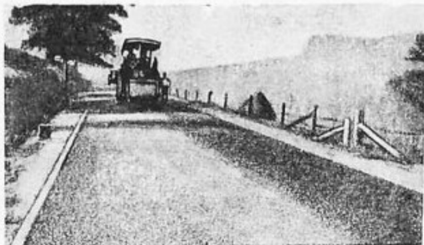
Укатка одежды, устроенной из холодного асфальта
